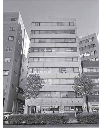
2社が入居していた建物
